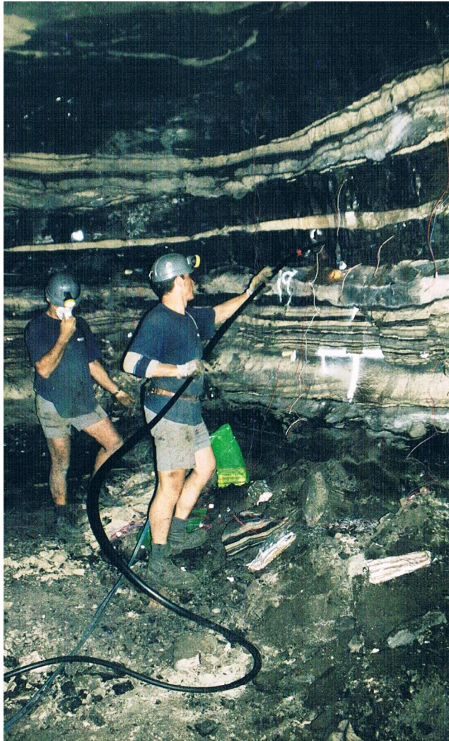
Fotografia 7. Interior d'una de les galeries d'avanç de la mina "San José", explotada per l'empresa minera LA CARBONÍFERA DEL EBRO, S.A (Arxiu Autor, Agost 2004).
