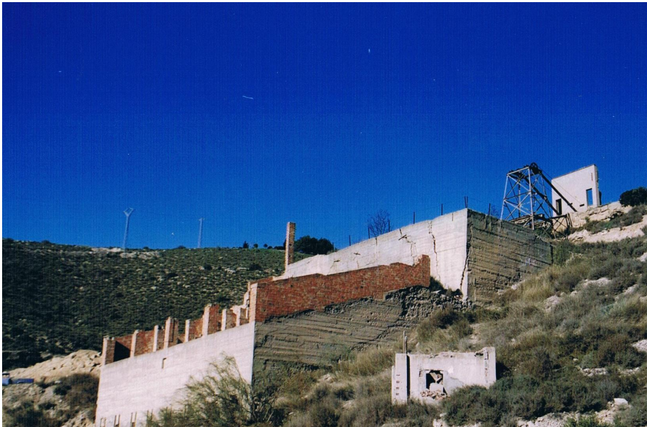
Fotografia 8. Vista de les instal·lacions de superfície de la concessió minera Virgen del Rosario, o mina del Barranc de Montnegre, al terme de Mequinensa. Arxiu Autor (Desembre 2002)
