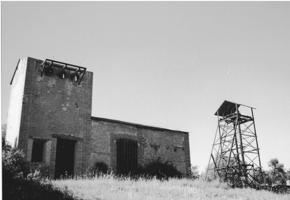
Foto 2. Situació de la "casa de màquines" on es va instal·lar el motor elèctric per accionar el cable de les politges del castellet metàl·lic i la torre del transformador elèctric, adossada al mateix edifici. (Arxiu autor, juny 2002).
