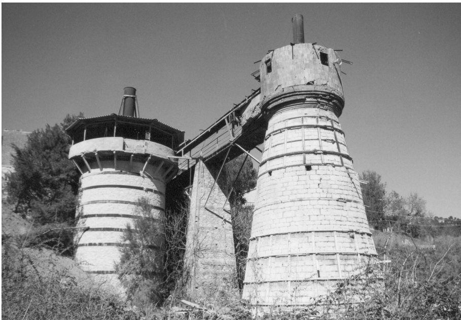
Figura 2. Forns de calç construïts en forma de torre de gran alçada, situats al peu de la pedrera de calcàries triàsiques "Vallsallent" que fins fa pocs anys explotà l'empresa Piedras y Derivados, S.A (Castellar del Vallès, Vallès Occidental). Arxiu Sergi Falguera Torres
