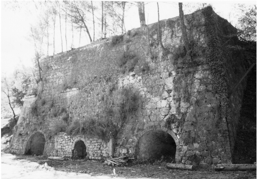
Figura 11. Fàbrica de calç, ciments naturals i artificials de forn vertical. Sant Martí de Centelles (Osona). Autor fotografia: Arxiu Sergi Falguera Torres.
