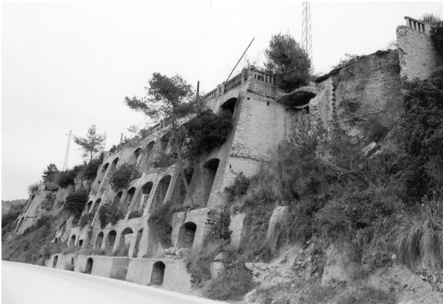
Figura 5. Conjunt de forns de calç construïts un a sobre de l'altre formant nínxols a la pendent del terreny. ( Sitges , Garraf). Autor fotografia: Arxiu Sergi Falguera Torres
