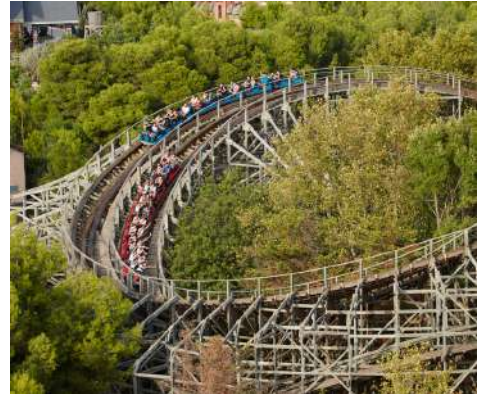
Imatge 35. Imatge on podem observar l'estructura de fusta de la Stampida, i la petita diferència de distància entre els dos vagons. Imatge extreta de https://www.portaventura-world.com/atracciones/stampida
