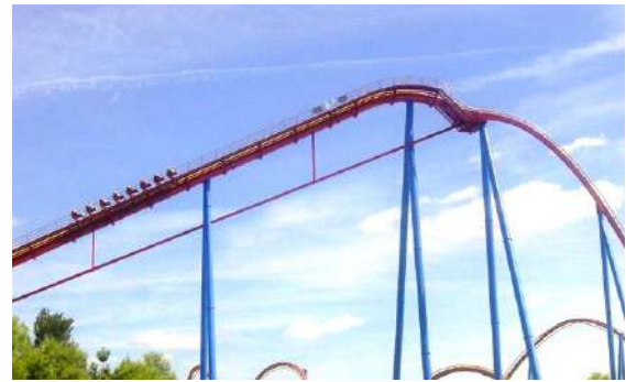
Imatge 94. Exemple de pilars en forma de Y a la muntanya russa Superman del Parc Warner de Madrid. Imatge extreta de https://www.freizeitpark-welt.de/freizeitparks/wbmwm/mwm_start.php?attractionid=c37
